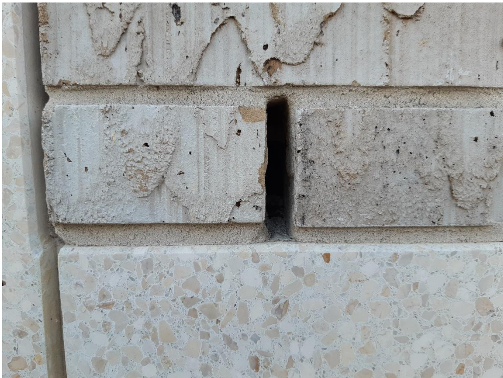
Figuur 9. Bij het gebouw dat in Figuur 8 te zien is zijn open stootvoegen toegepast. Zodoende is het mogelijk geschikt voor vleermuizen om er een verblijfplaats te vinden.
