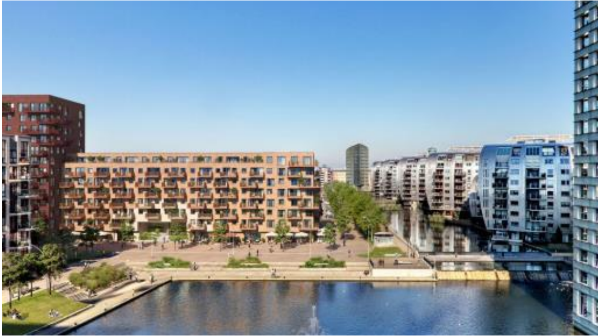
Figuur 2. Artist impression van het in aanbouw zijnde gebouw Palazzo (links op de afbeelding), afkomstig van de site https://www.woneninpalazzo.nl/ . Het plangebied ligt tussen dit gebouw en de Hofvijver (op de voorgrond).
